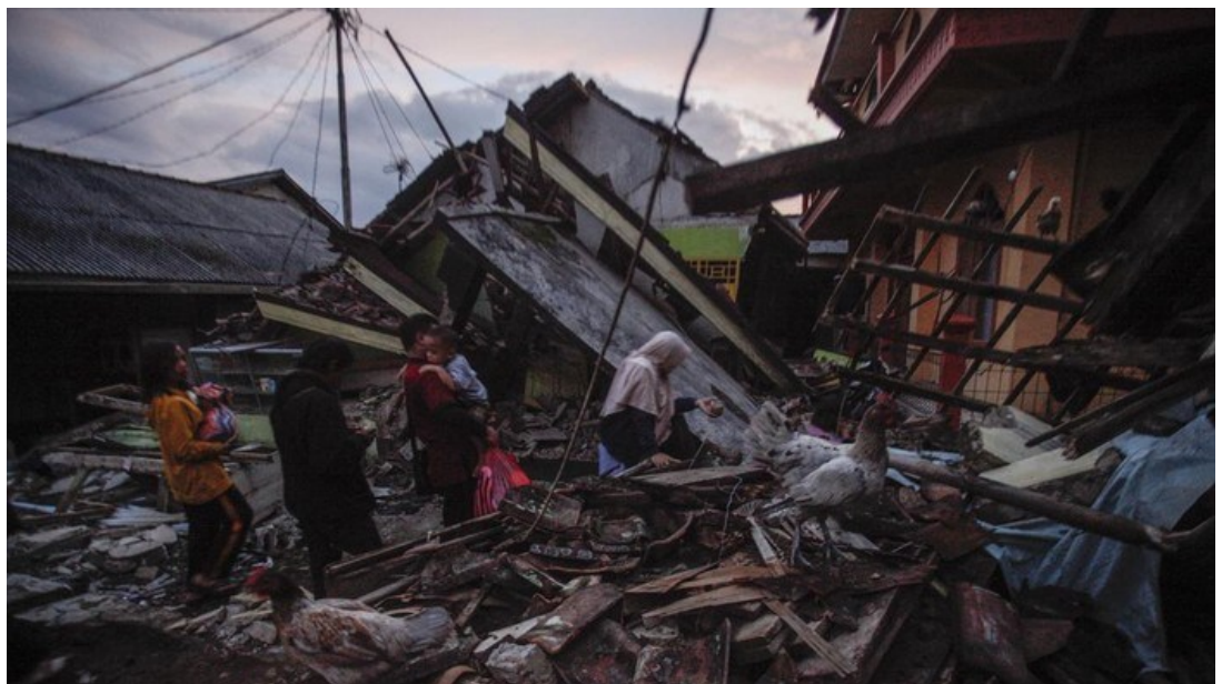
Gambar 8. Rumah warga rusak berat akibat gempa bumi Barat Daya Kabupaten Cianjur, Senin 21 November 2022 jam 13:21:10 WIB
