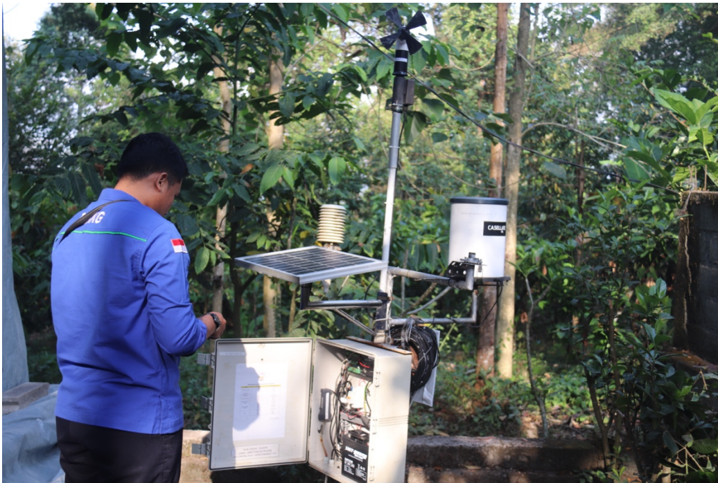
Gambar 5. Instalasi AWS sebagai bagian KIMONO Smart Warning
