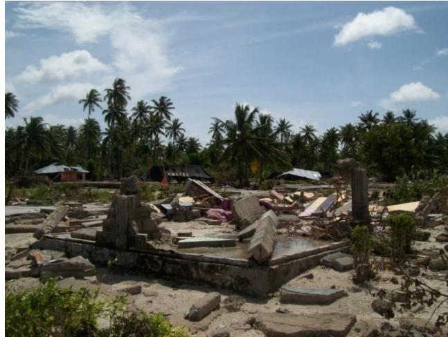
Bangunan dengan tiang beton pun runtuh diterjang tsunami (BMKG2010)
