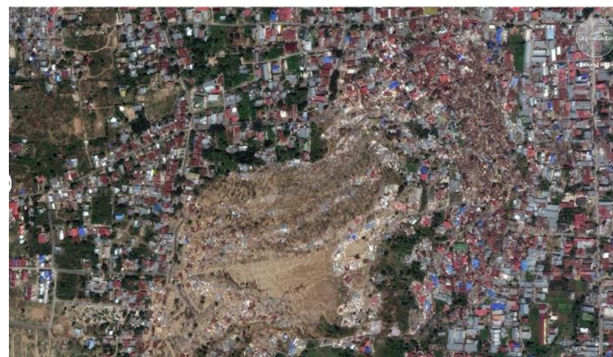
Setelah gempa (Google Earth, 1 Oktober 2018)
