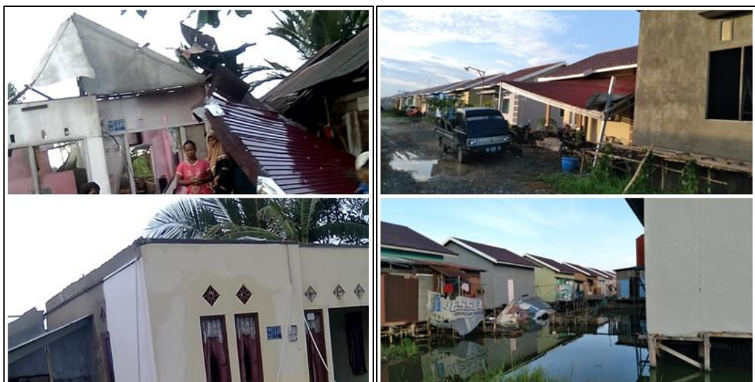
Gambar 2. Rumah terdampak kejadian angin kencang Sumber: BPBD Barito Kuala
